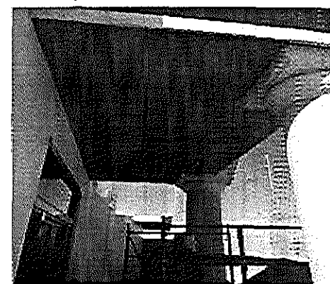
6 Plafond rigido de durock en acceso
