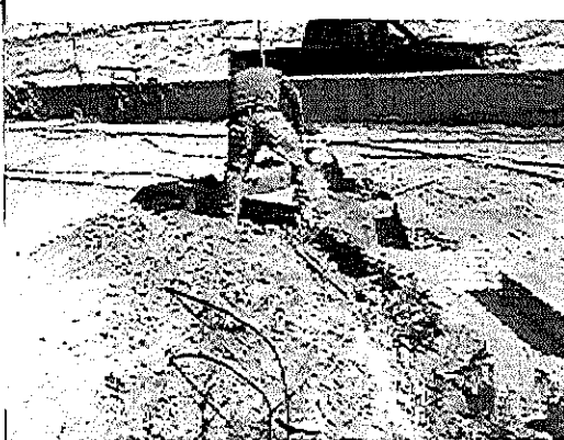
4 Demolicion de Guarnicion
