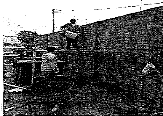
11 Construccion de barda de block
